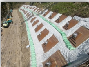
例) のり面にアンカー工を施行
