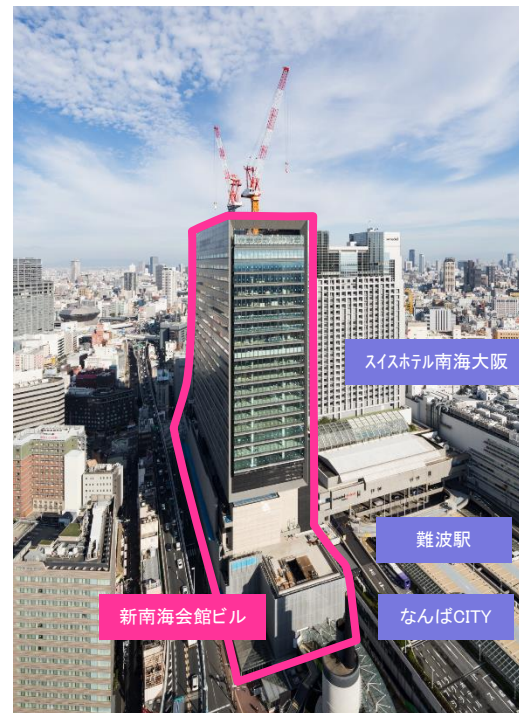
2017年10月の新南海会館ビル建設工事 現地写真
