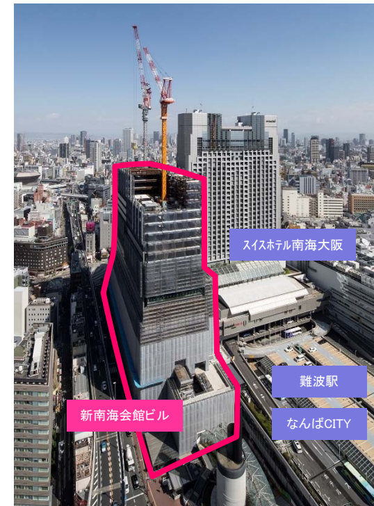
2017年4月の新南海会館ビル建設工事 現地写真
