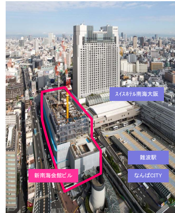
2016年10月の新南海会館ビル建設工事 現地写真
