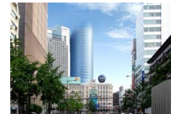
新南海会館ビルイメージ (建替推進中)
