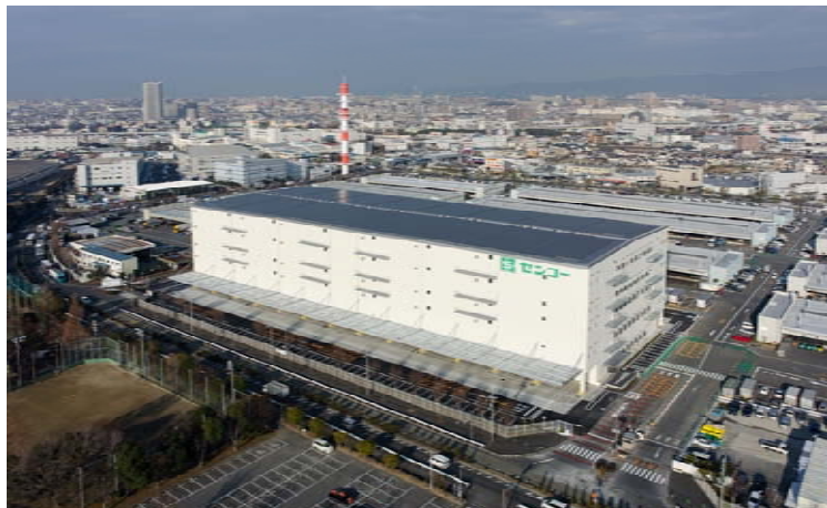
北大阪トラックターミナル物流センター(2号棟)
