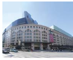
南海ビル外壁美装化
