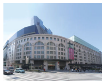
南海ビル外壁再生
