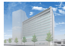
南海なんば第1ビル 南海電気鉄道株本社 (大阪府立大学入居 2013年4月開学予定)
