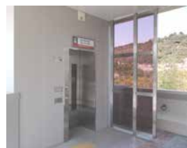
美加の台駅に整備したエレベーター
