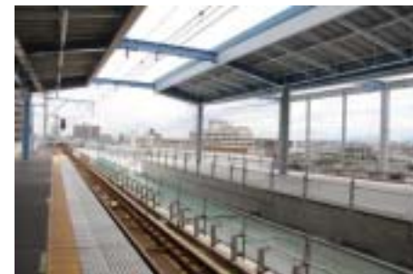
建設中の泉大津連立
