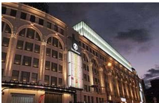
南海ビル改修
