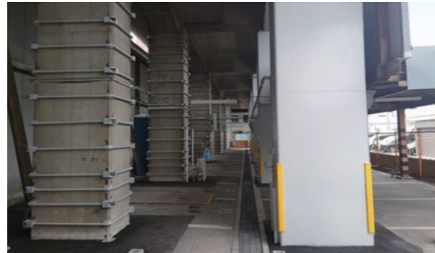
湊駅～石津川駅間 高架橋柱耐震補強工事
