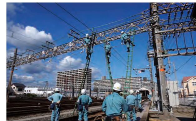
電力係員による復旧訓練
