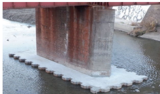
津田川橋梁洗掘防止対策工事
