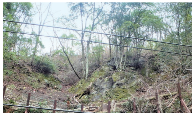
危険樹木 伐採前(上)、伐採後(下)
