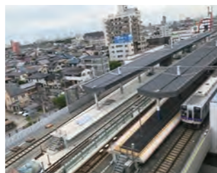
高石市内連続立体交差事業 (高石駅)
