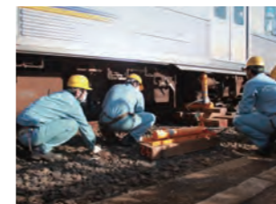
検車係員による復旧作業
