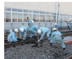
保線係員による復旧作業
