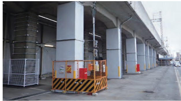
高架橋柱の耐震補強(柱に鋼板を巻き補強)
