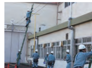
電力係員による復旧作業
