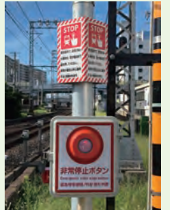
踏切の非常停止ボタン
