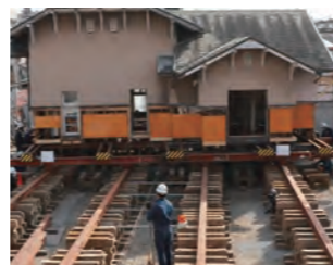
堺市内連続立体交差事業 (諏訪ノ森駅旧駅舎の曳家工事)
