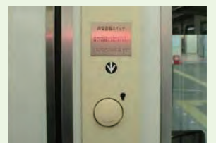
車内非常通報装置
