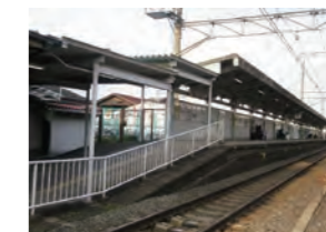
【吉見ノ里駅】スロープの整備 スロープの距離を長くすることで、こう配を緩和
