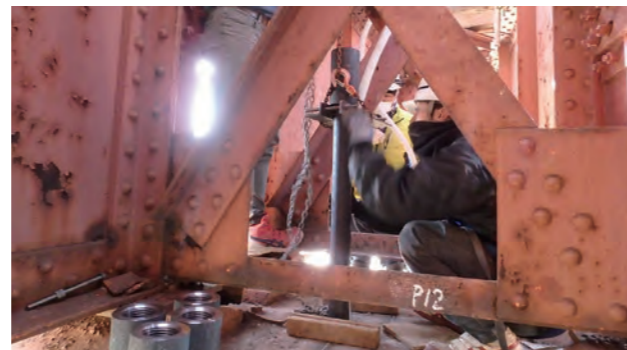
南海本線 紀ノ川橋梁の橋脚補強(鋼棒の挿入)
