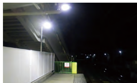
駅ホーム照明の増設
