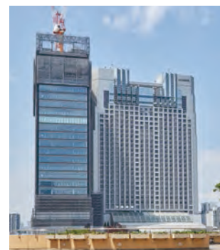
建設が進む新南海会館ビル（仮称）（左）
