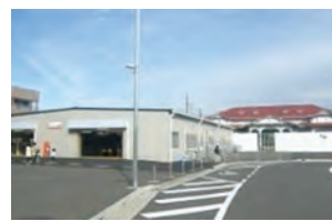
南海本線 (堺市内) 連続立体交差事業 (浜寺公園駅駅舎)
