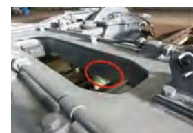
台車の亀裂発生場所
