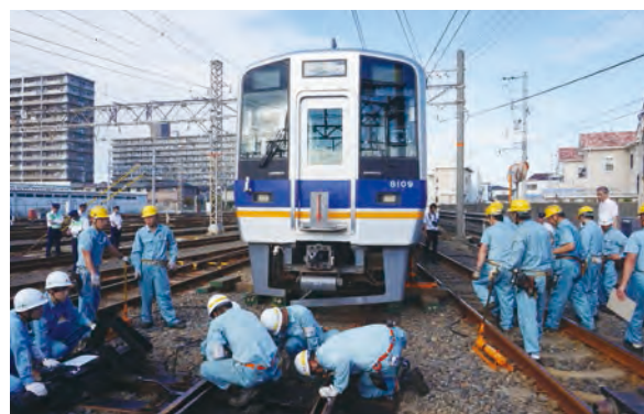
事故復旧総合訓練
