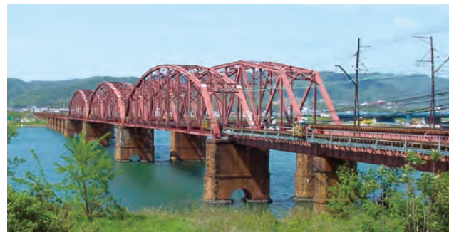
南海本線 紀ノ川橋梁
