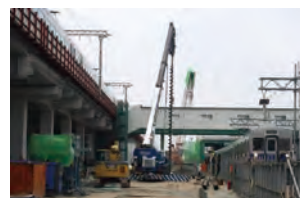
南海本線 (高石市内) 連続立体交差事業
