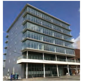
南海和歌山市駅ビルオフィス棟
