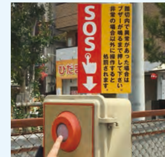
踏切の非常ボタン
