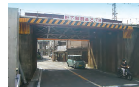
桁下有効高表示と防護柵
