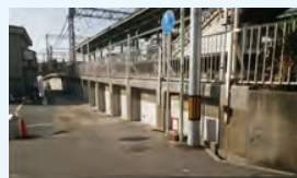
補修後のコンクリート構造物 (北野田駅)
