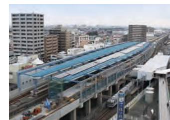
南海本線泉大津駅ホーム屋根上②
