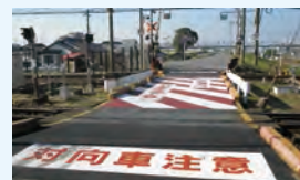
カラー舗装後の踏切道 (紀ノ川駅～和歌山市駅間)
