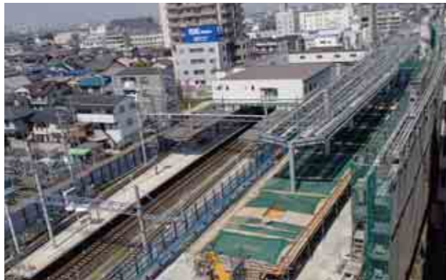
南海本線高石駅の工事の様子
