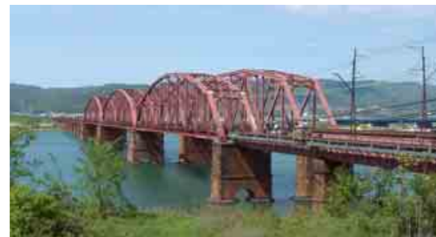
南海本線・紀ノ川橋梁
