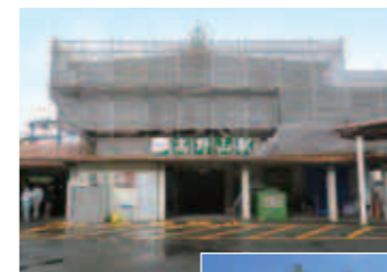
工事中の高野山駅
