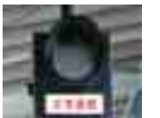
非常通報表示灯
