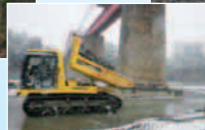
橋げたの復旧工事
