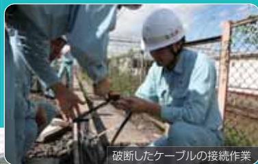
破断したケーブルの接続作業
