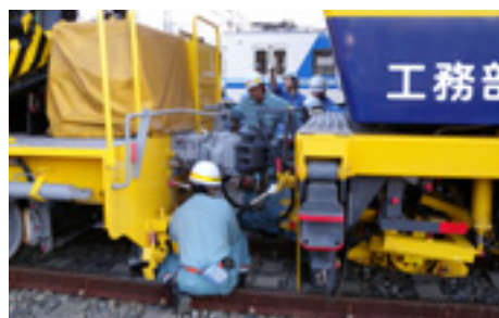
車両現場での訓練の様子
