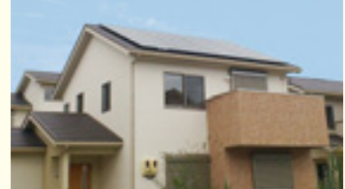
太陽光パネル付住宅
