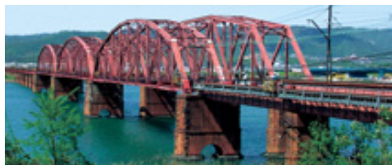
南海本線 紀ノ川橋梁
