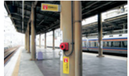
非常通報ボタン
