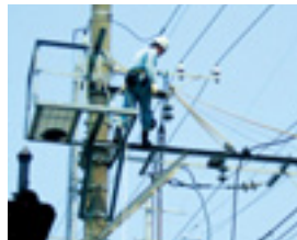
電路柱上作業訓練風景
