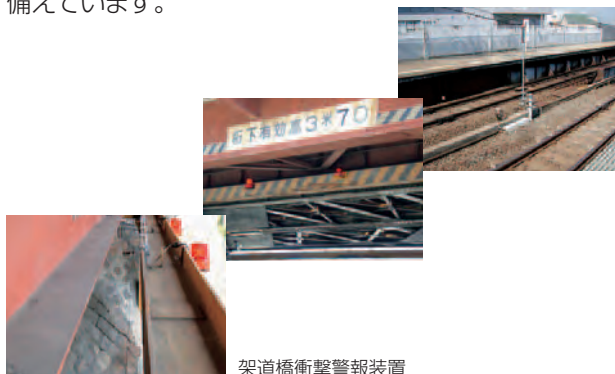
架道橋衝撃警報装置
