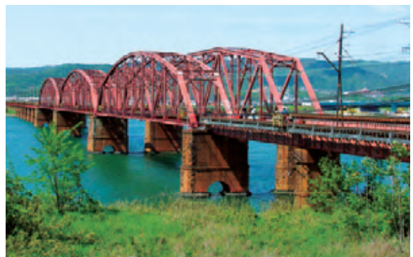
南海本線 紀ノ川橋りょう
