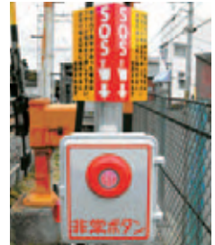
踏切支障報知装置
