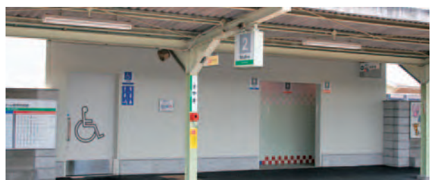
バリアフリー化工事を実施した狭山駅のトイレ
