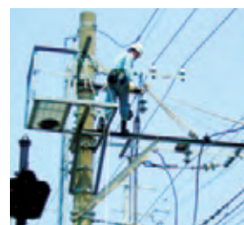
電路柱上作業訓練風景
