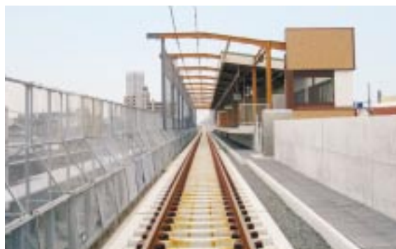
弾直軌道の敷設
