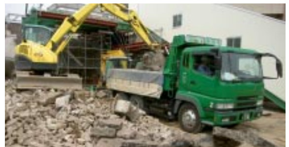
コンクリート塊の積み込み状況
