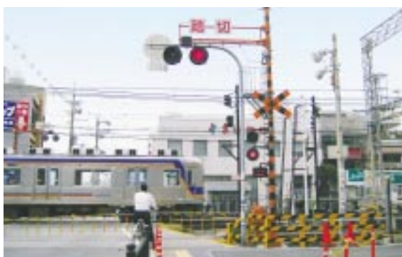
踏切警報機の視認性改善
