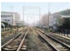
ロングレール
