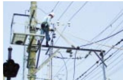
電路柱上作業訓練風景
