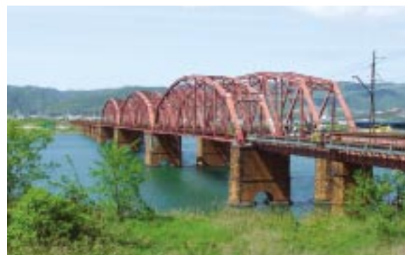
南海本線 紀ノ川橋りょう
