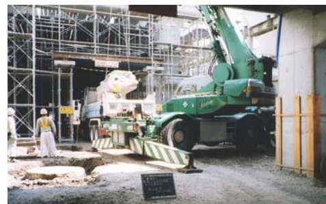
建設リサイクル法対象工事の様子
