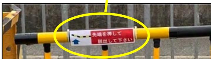
スリット型遮断桿(折り曲げて踏切外へ脱出する)
