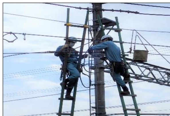
電線路設備復旧訓練 (施設部・電力担当)
