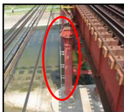
河川水位警報装置・17 か所
