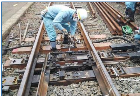
分岐器実技訓練 (施設部・工務担当)
