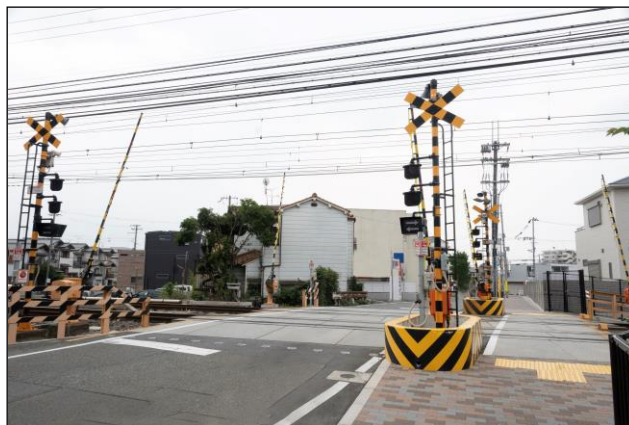
高野線 白鷺3号踏切(2021年度完成)
