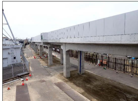
高師浜線の高架工事
