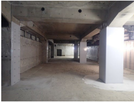
難波駅～今宮戎駅間耐震補強工事
