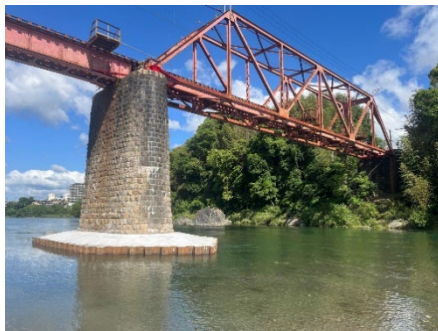
高野線紀ノ川橋梁 P1橋脚(完了)
