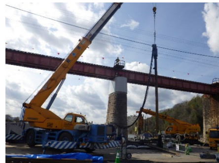
高野線紀ノ川橋梁 P2橋脚(施工中)
