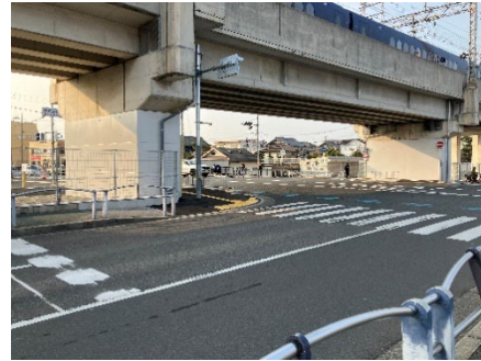
岸和田駅～蛸地蔵駅間耐震補強工事
