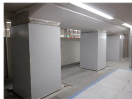
岸里玉出駅耐震補強
