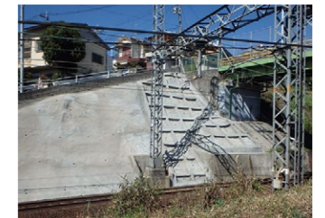
法面崩壊対策(千代田駅～河内長野駅間)
