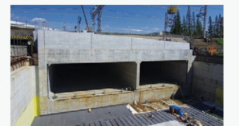
道路と線路との立体交差工事
