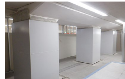
岸里玉出駅耐震補強
