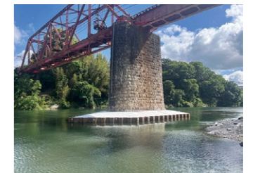
洗掘防止対策(高野線紀ノ川橋梁)
