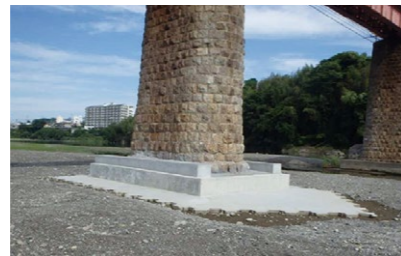
高野線紀ノ川橋梁P3橋脚洗掘防止対策工事
