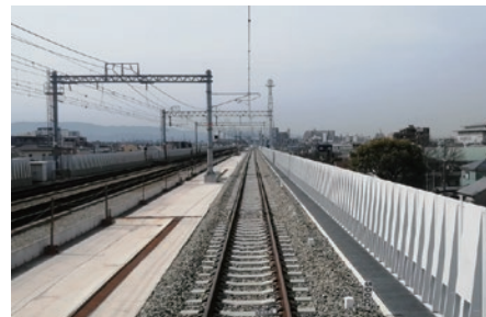
南海本線高石市内連続立体交差事業(高師浜線高架部)
