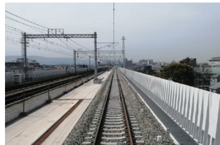
南海本線高石市内連続立体交差事業(高師浜線高架部)
